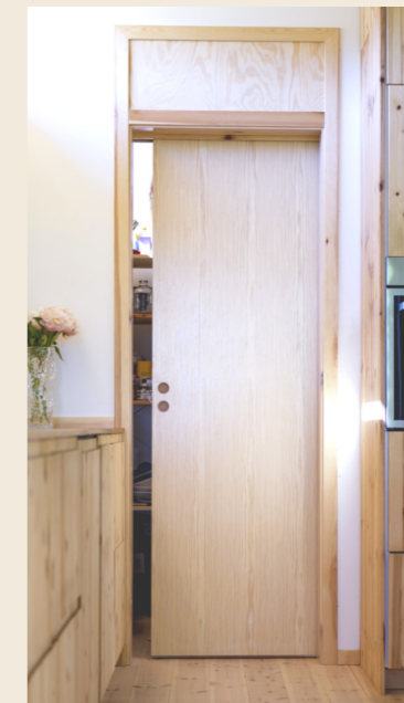
Skyvedør med kompakt dørblad i furu finér og overfelt
